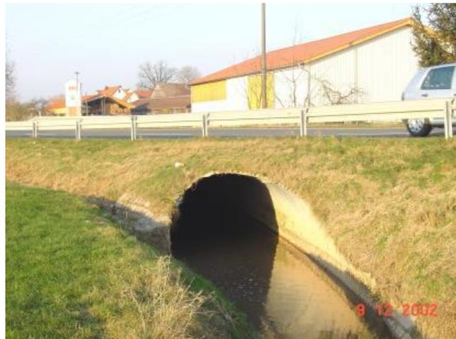
Die Brückenprüfung hat die Notwendigkeit eines Ersatzneubaus des Wellstahlrohres ergeben. Dies könnte entweder wieder durch ein Wellstahlrohr erfolgen, alternativ könnte aber auch ein Stahlbetonrahmen-Fertigteile Verwendung finden. Des Weiteren ist das Anbringen von fachgerechten Schutzeinrichtungen (Schutzplanken und Geländer) erforderlich.
